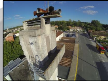
Inspection d'ouvrages d'art
